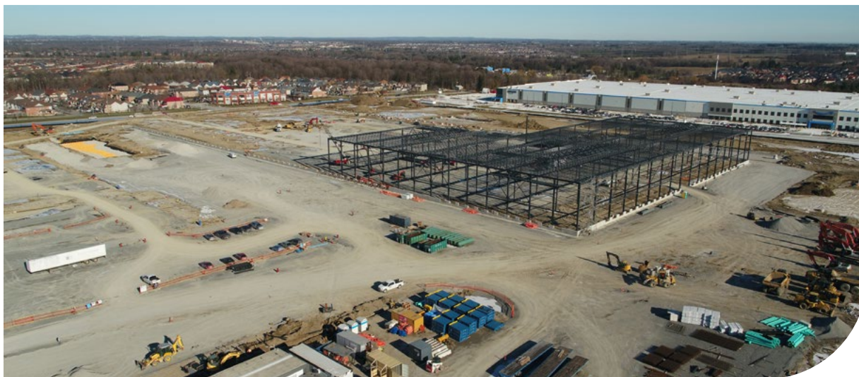
Prise en janvier 2021, cette photo montre notre nouveau Centre de traitement de l'est de l'Ontario, une installation de pointe en construction dans le nord-est de Toronto. En haut à gauche, on peut voir un bassin de stockage pour la gestion des eaux pluviales.
